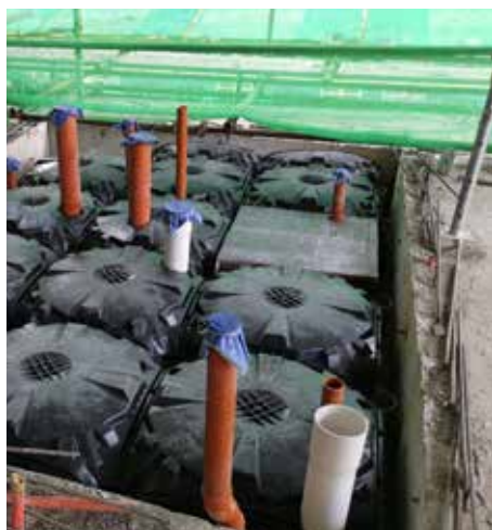
Sunken Slab Filling
