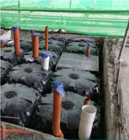
Sunken Slab Filling
