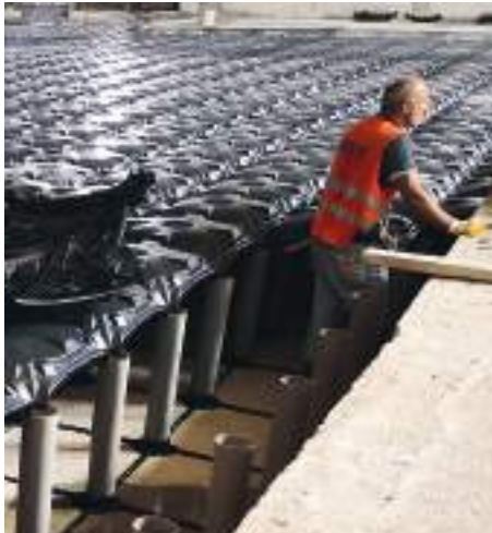
Sunken Slab Filling
