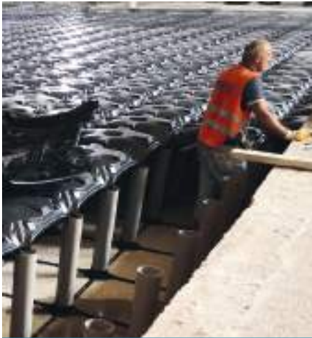
Sunken Slab Filling
