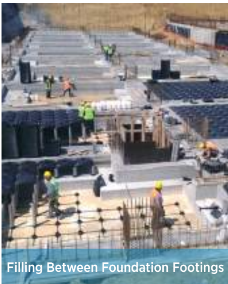
Sunken Slab Filling
